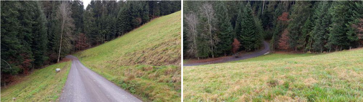
Abbildung 5 Steilhang oberhalb der Strasse (Abbauperimeter)
